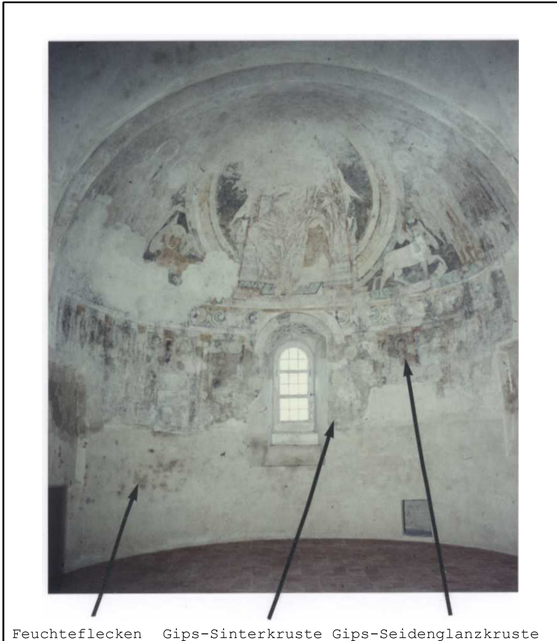
Abb. 4: Die Wandmalereien in der Apsis der Kirche in Eilsum um 1970. Foto aus dem Archiv des Instituts für Denkmalpflege, Hannover.
