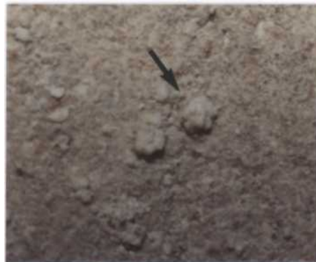
Abb. 37: Einzelne Pustel der Blumenkohlkruste auf der Apsiswand. Ø der Pustel ca. 2mm.
