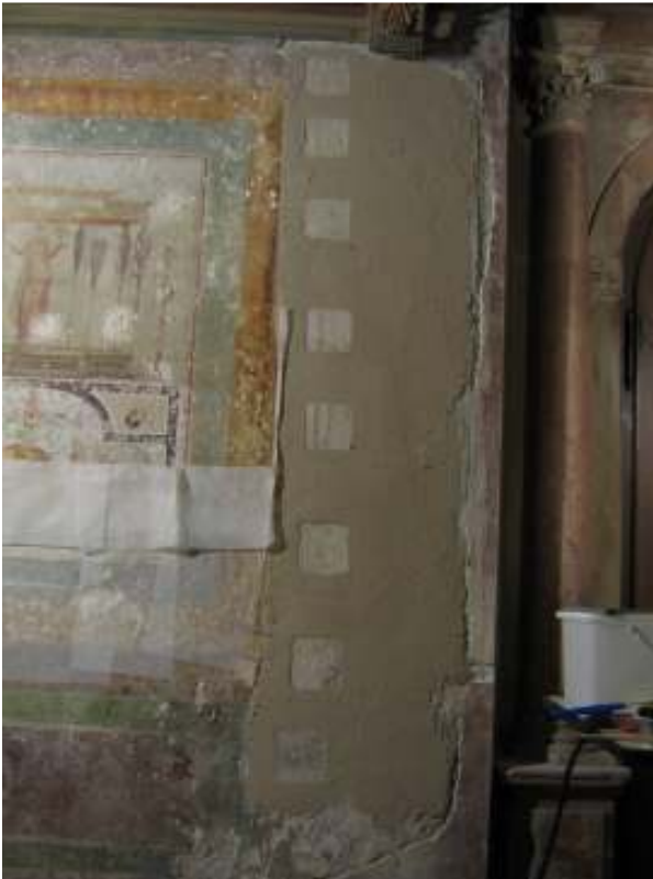
Abbildung 17: Bemusterung eines Kompressenfeldes mit handschriftlichen Aufzeichnung zu den Leitfähigkeitsmessergebnissen)(Foto: Markus Eiden, genehmigt durch Hubertus Fürst Fugger-Babenhausen und die Fürst Fugger-Babenhausen'sche Stiftung zur Förderung schwäbischen Kulturgutes)
