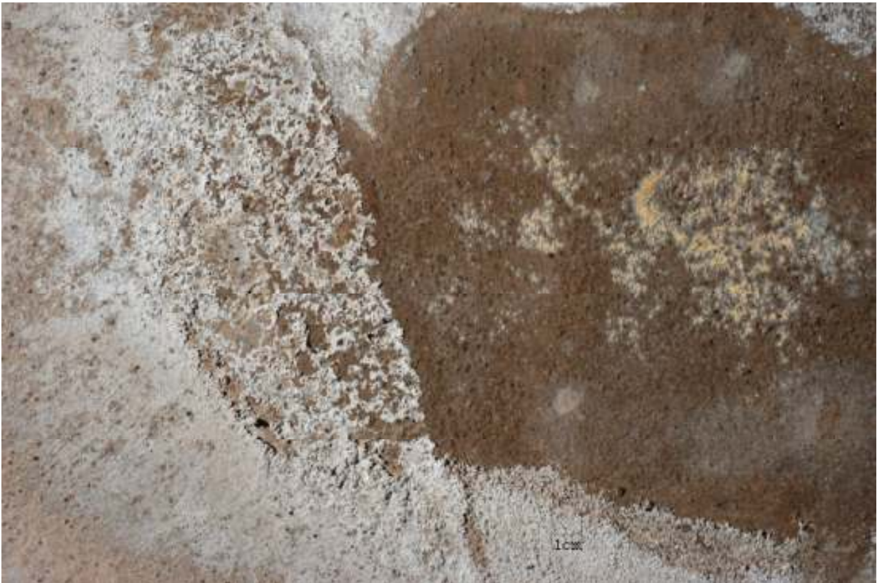
Abbildung 2: Residenz Würzburg, Treppenhausfresko, Gewölbe-West, Detail Salzleck (Zustand 2003) (Foto: M. Eiden, genehmigt durch Bayerische Verwaltung der staatlichen Schlösser, Gärten und Seen, Schloss Nymphenburg, 80638 München)
