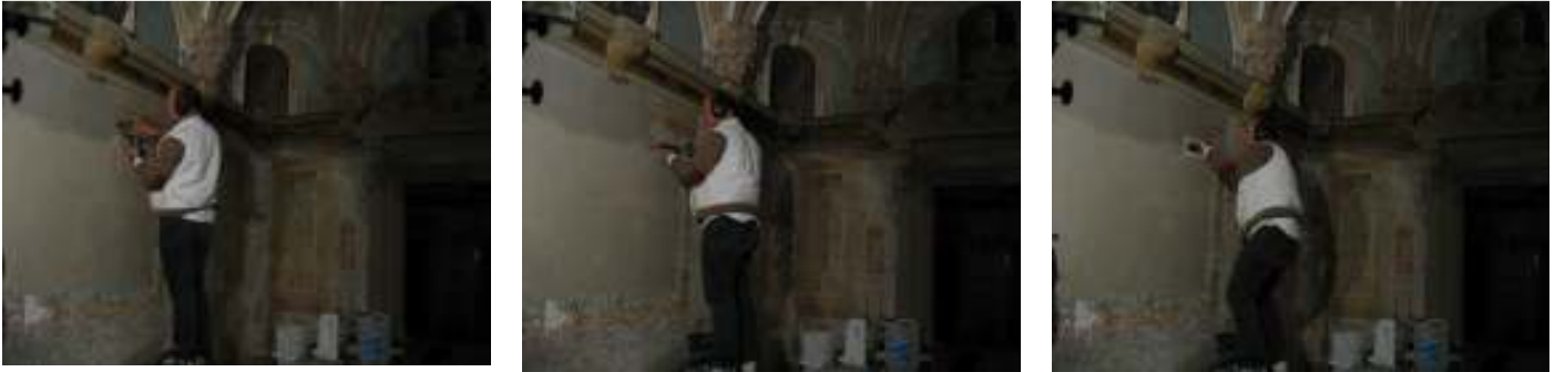
Abbildung 14-16: Bilderfolge Kompressenapplikation. (Fotos: Markus Eiden, genehmigt durch Hubertus Fürst Fugger-Babenhausen und die Fürst Fugger-Babenhausen'sche Stiftung zur Förderung schwäbischen Kulturgutes)
