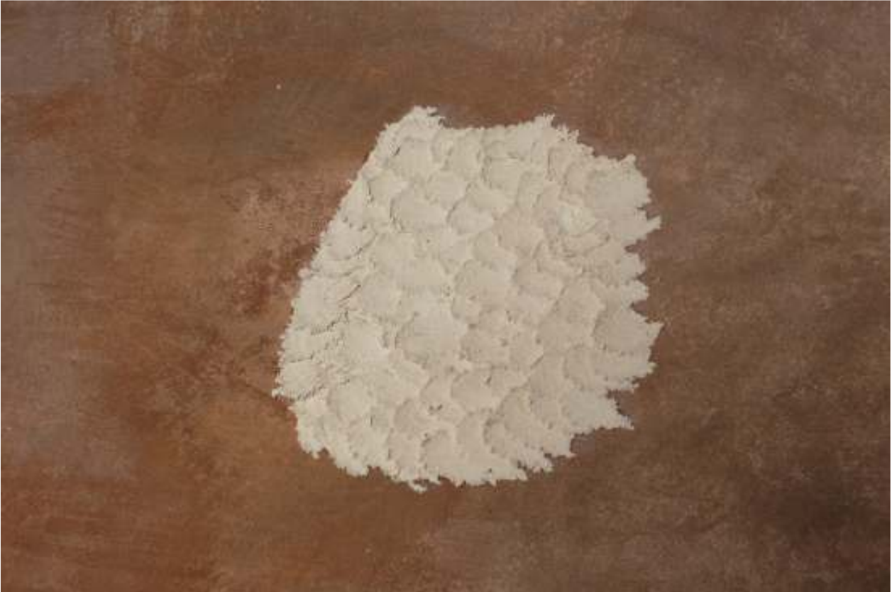
Abbildung 7: Mineralische Salzverminderungskompressenanwendung im Kaisersaal. (Foto: M. Eiden, genehmigt durch Bayerische Verwaltung der staatlichen Schlösser, Gärten und Seen, Schloss Nymphenburg, 80638 München)
