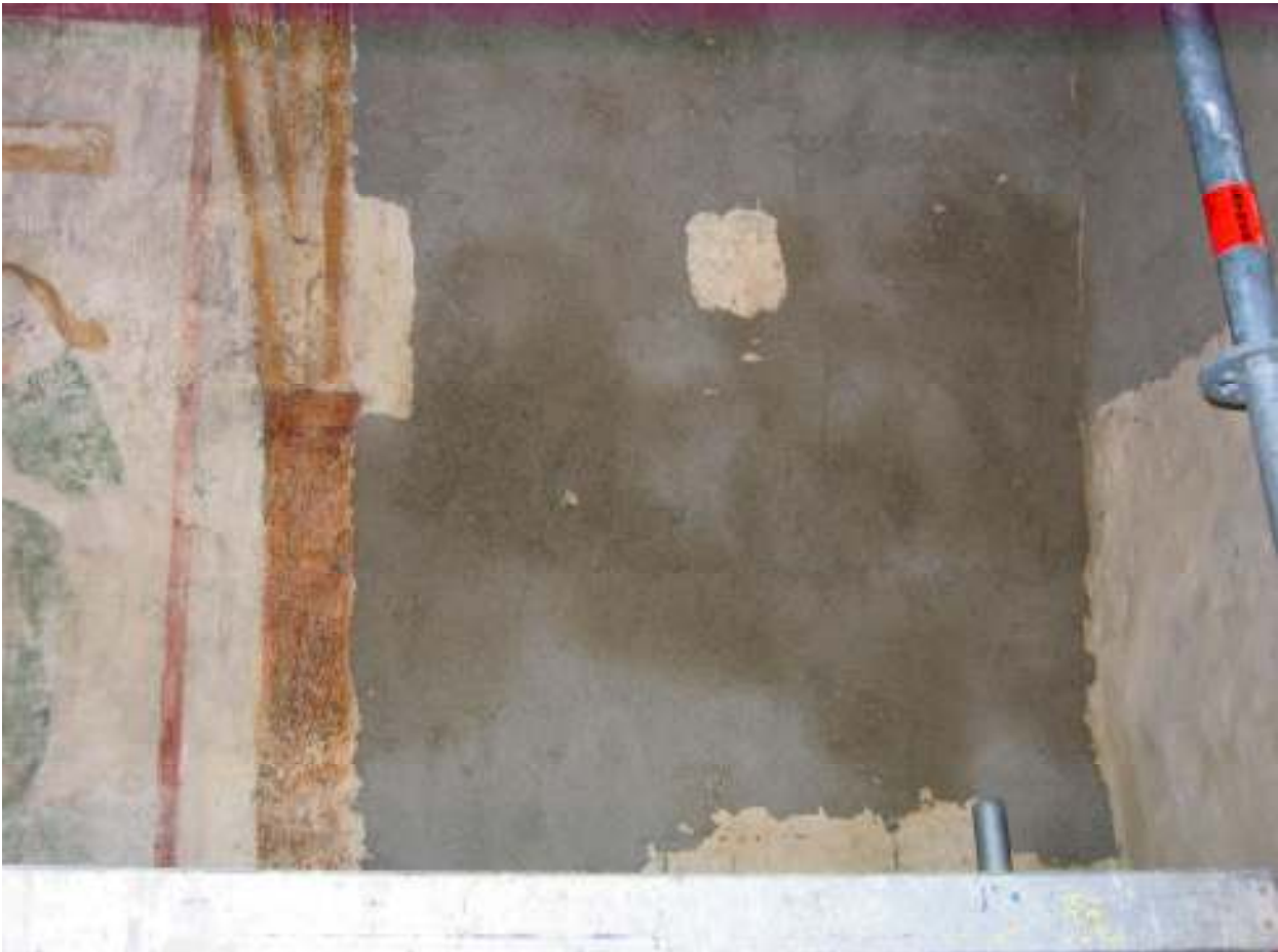
Abbildung 21: Detail Kompresse Pflaumloch, Hygroskopische Eigenschaften (Foto: Markus Eiden)
