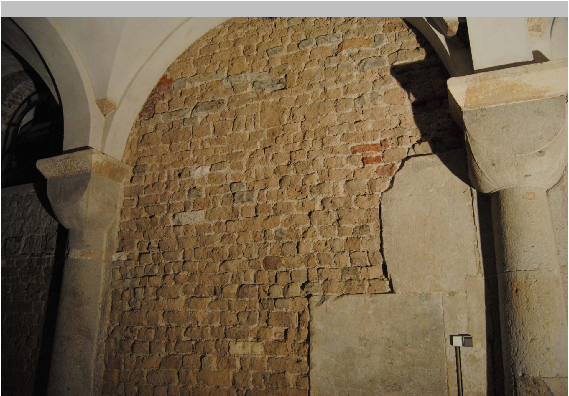
Die Wände und Pfeiler der Krypta bestehen aus Natursteinen, hier Tuffstein
