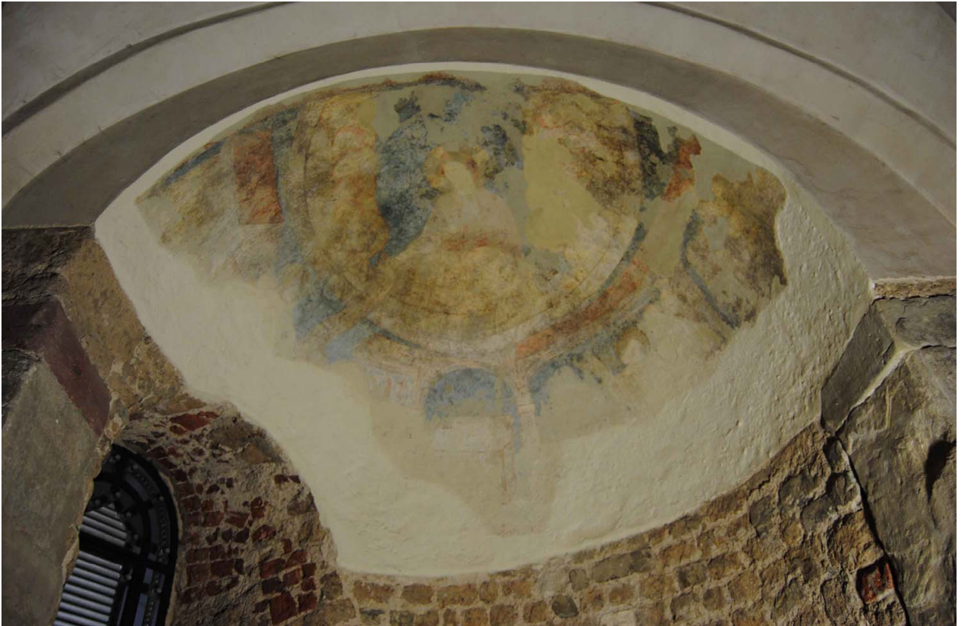
Reste romanischer Wandmalereien befinden sich in den Gewölben der Konchen
