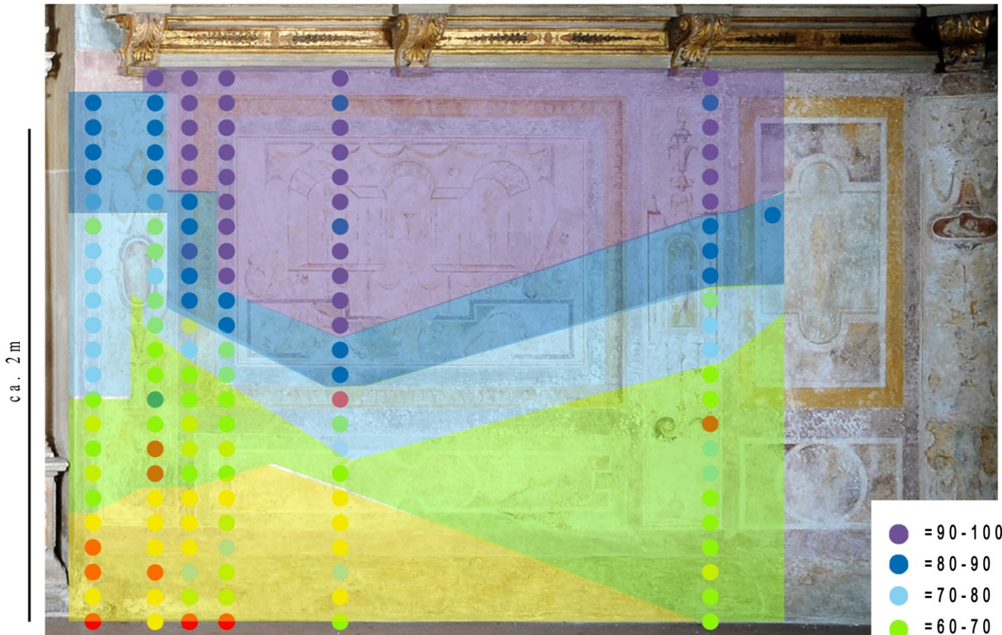
Augsburg, Fuggerhaus, Musensaal 3/2010 Feuchtemessung mittels GANN-Hydromette
