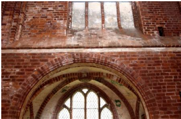
Abb. 13: Musterfläche der großflächige Kompressenanwendung
