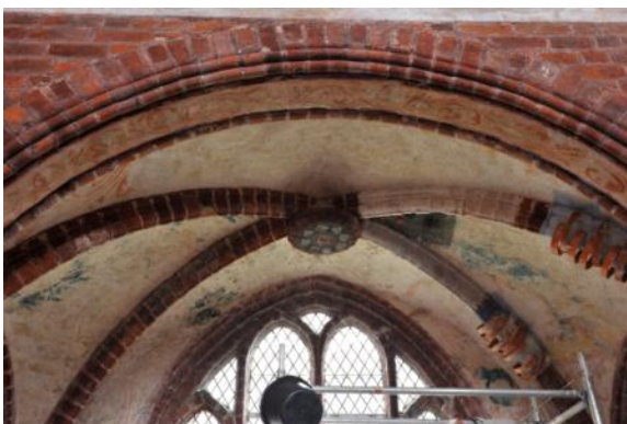
Abb. 13: Musterfläche der großflächige Kompressenanwendung
