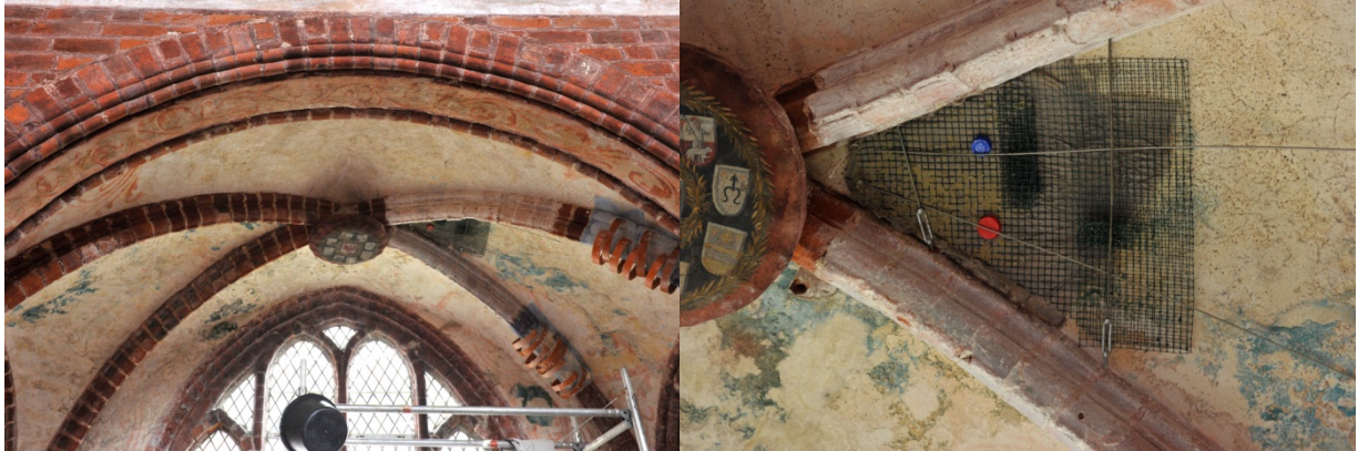
Abb. 17: Kompressenauftrag mit/ohne haftungsunterstützender Hilfskonstruktion
