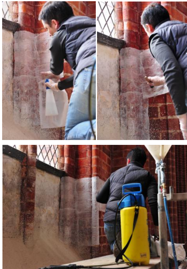
Abb. 14: Auftrag der Zellstoffkaschierung
