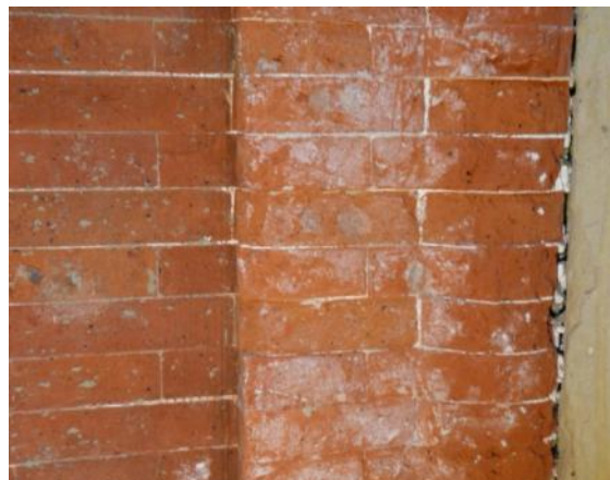
Abb. 12: Ziegeloberfläche nach Abnahme eines stark kaolinhaltigen Kompressentypus an dem Versuchsobjekt de Waag / Amsterdam
