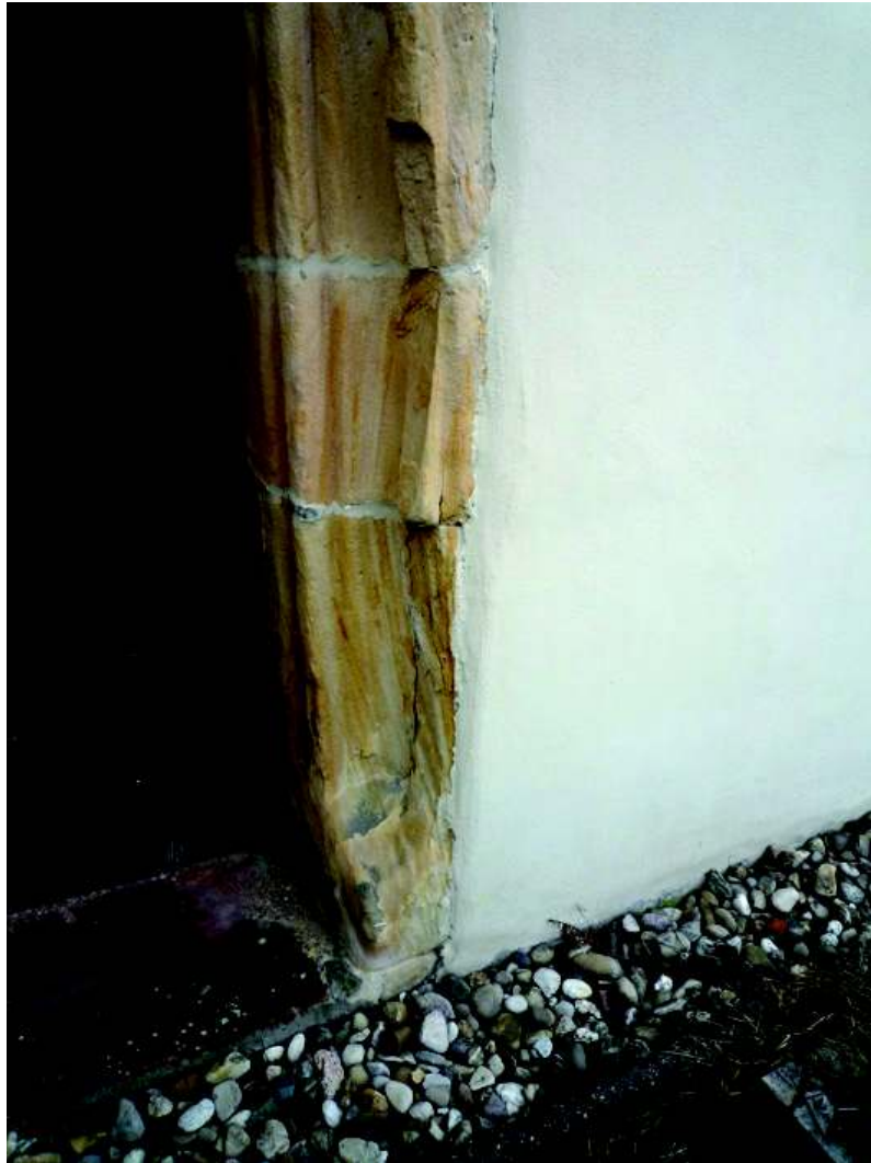
Abbildung 32: Durch den Sanierputz wird die Trocknung über die Putzfläche behindert. Daher wird der Feuchte- und Salztransport in die Gewände aus kapillar saugfähigem Sandstein umgeleitet. Die Folgen sind zwar eine schadensfreie Sanierputzoberfläche, gleichzeitig aber eine extreme Verwitterung des historischen Sandsteingewändes. (Foto: M. Auras)
