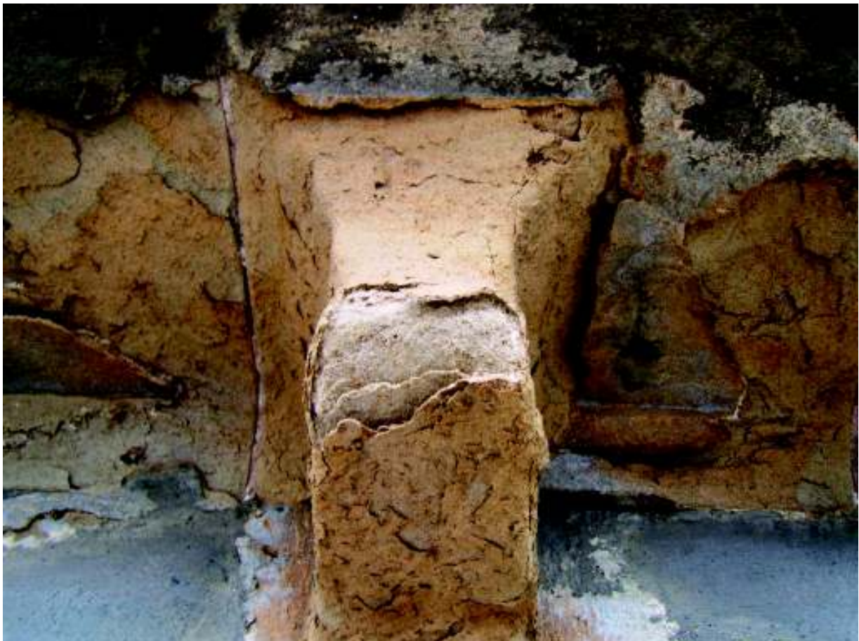
Abbildung 29: Der durch Salzbelastung tiefgründig geschädigte Sandstein hat seine Originaloberfläche fast vollständig verloren. (Foto: M. Auras)
