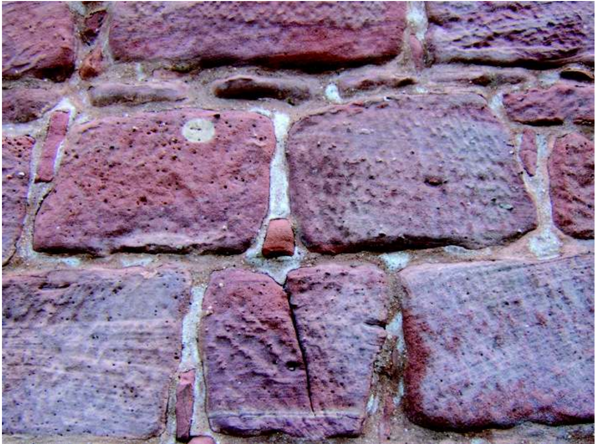
Abbildung 33: Verfugung eines extrem salzbelasteten Ruinenmauerwerks aus Sandstein mit einem Mörtel auf Basis natürlich hydraulischen Kalkes im Trockenspritzverfahren. Salz wandert bevorzugt in den Mörtel und kristallisiert auf der Fugenoberfläche aus. (Foto: M. Auras)
