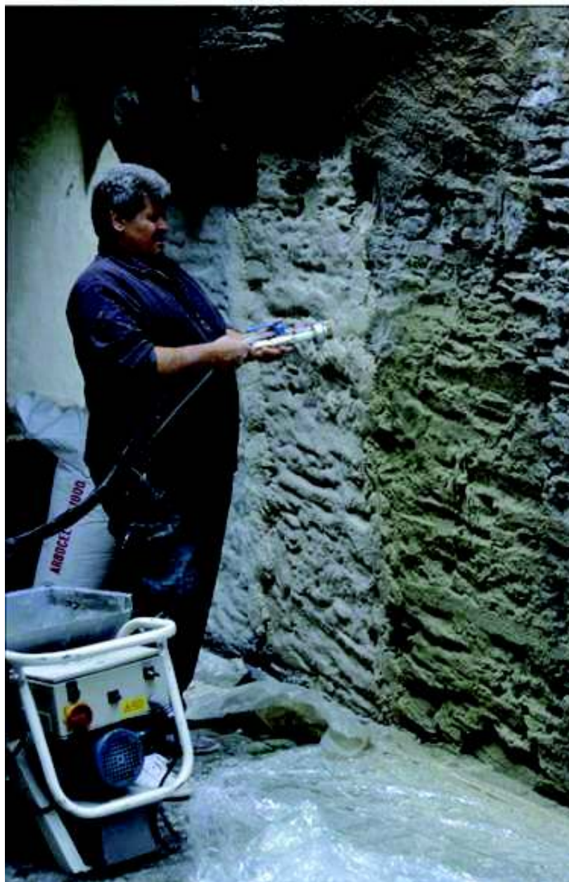
Abbildung 31: Aufbringen verschiedener Kompressenmaterialien mit der Putzmaschine. (Foto: P. Egloffstein)
