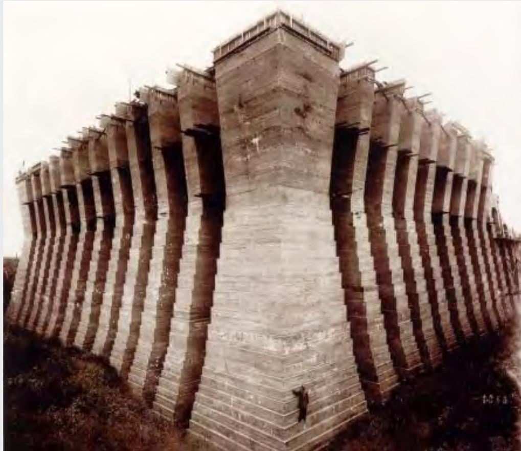
Gewicht ca. 300.000 t . Beton ca. 120.000 m<sup>3</sup> . Zement ca. 20.000 t . Kiessand 190.000 t
