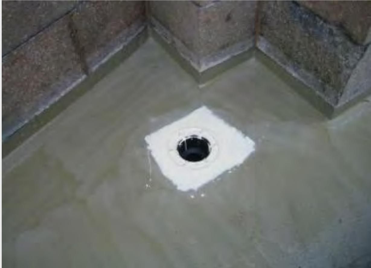
Flüssigabdichtung in den Umgängen . Inliner in den Abflussleitungen
