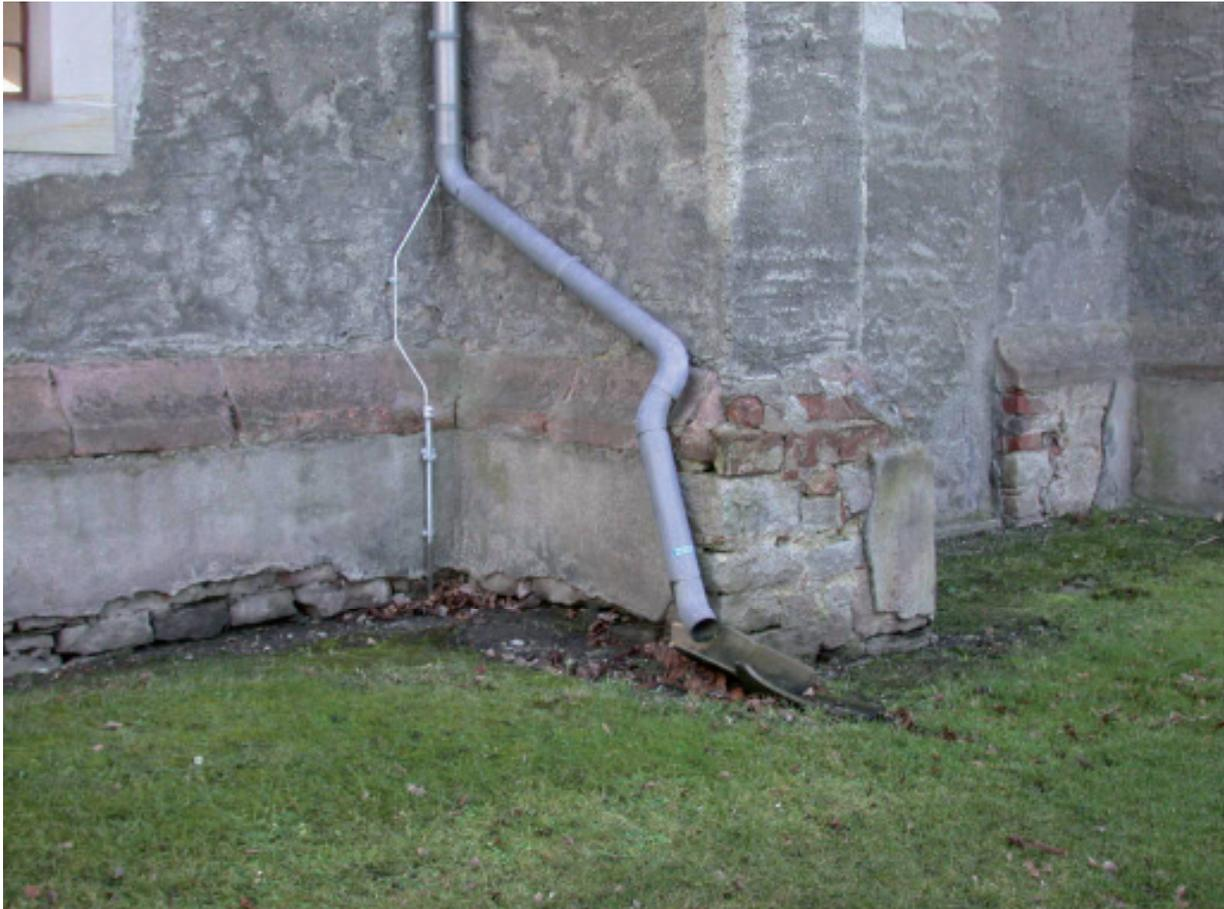
**Abbildung 21: Auch noch so aufwändige Konstruktionen nützen wenig, wenn das Wasser nicht weit genug vom Gebäude abgeführt wird (Foto: C. Franzen).**
