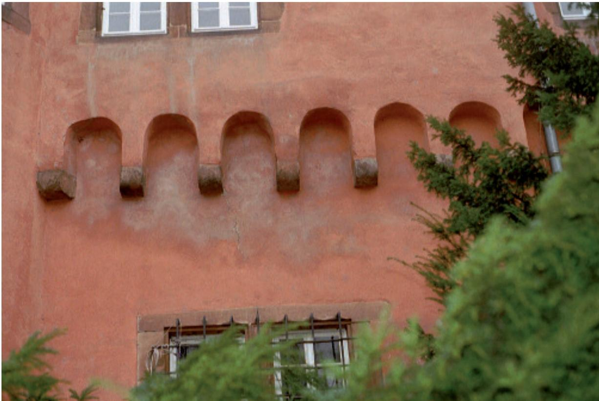
**Abbildung 20: Aufsteigende Feuchte kommt für diesen Schaden nicht in Frage, vielmehr sorgen hygroskopische Salze (Nitrate) für diese Oberflächenveränderungen (Foto: H. Juling)**
