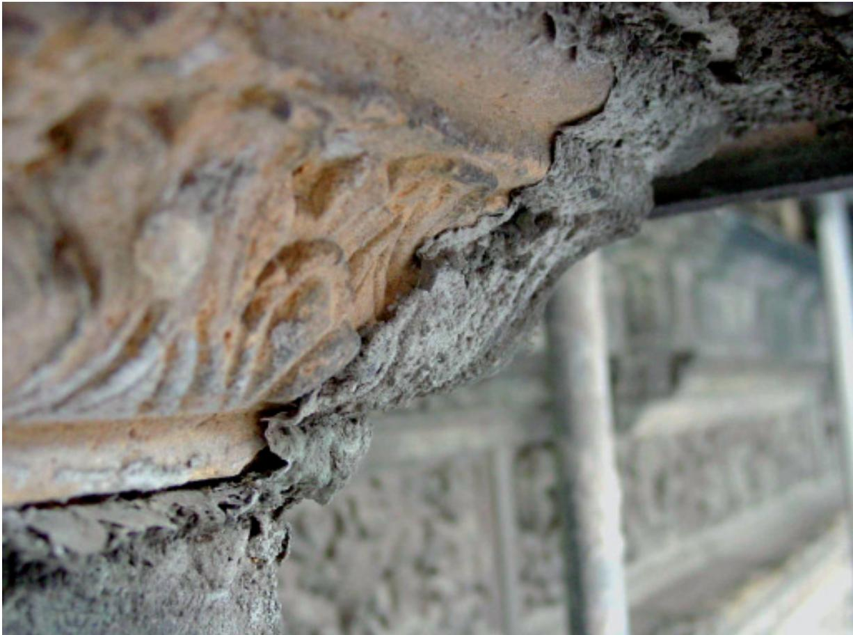
**Abbildung 19: Gipskrusten sind ebenfalls den Salzschiäden zuzurechnen, auch wenn sie nur oberflächlich aufsitzen. (Foto: C. Franzen)**
