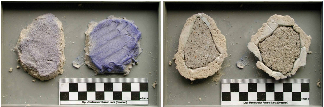
Abb. 2. Historischer Gipsmörtel mit aufliegender abgetrockneter Komresse über Japanpapier von der Ober- und Unterseite. Kompressenzusammensetzung: links: Sepiolith, Poraver®, Sand (1 : 3 : 8 Raumteile); rechts: Sepiolith, Acematt® HK 125, Sand (1 : 3 : 8 Raumteile) (Foto: Roland Lenz, 2006)
