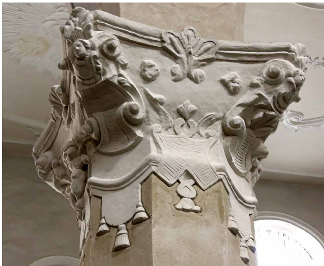
Abb. 6. Konstanz, Dreifaltigkeitskirche, Kapitell im Kirchenschiff mit aufgebrachtener Langzeitkomresse. Kompressenzusammensetzung: 5 RT „Spielsand“, < 1 mm Ø, 1 RT Sepiolith, 3 RT Poraver® Glasgranulat 0,04–0,125 mm Ø, 2 RT Marmormehl feinst. Applikation durch Restaurator G. Dürr, Freiburg. Betreuung der Maßnahme: Dr. D. Jakobs, LAD BW/Dr. Grüner, MPA Stuttgart/Prof. R. Lenz, ABK Stuttgart (Foto: ABK Stuttgart, Roland Lenz, 2011)
