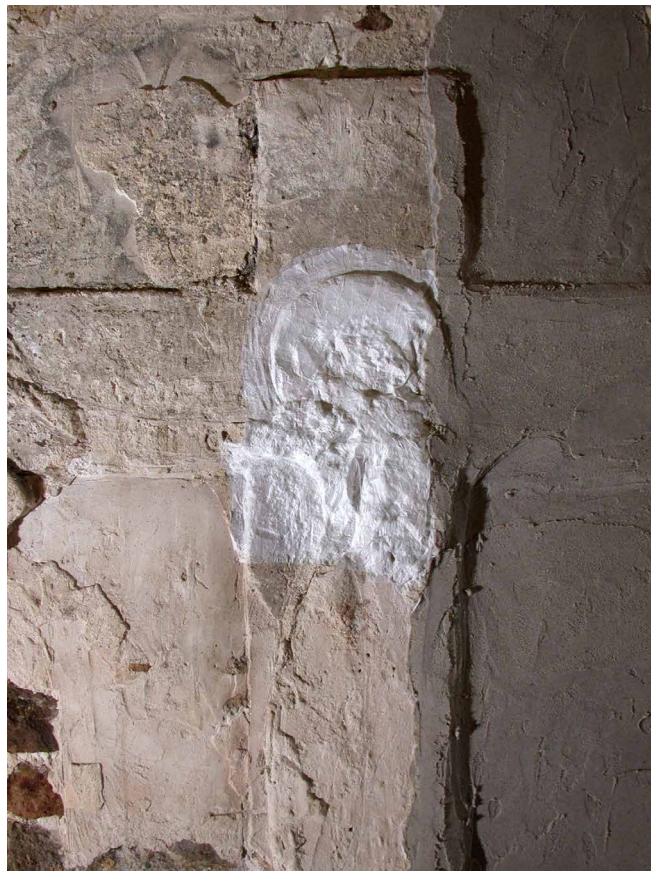
Abb. 7. Kloster Ilsenburg, Refektorium, Ostwand mit mittelalterlichem Gipsrelief aus Hochbrandgips. Teilweise aufgebrachtene Salzminderungskomresse über zweilagiger Japanpapierzwischenlage. Kompressenzusammensetzung: 8 RT Sand (12 mm) pH-neutral, 1 RT Sepiolith, 3 RT Acematt® HK 125; Salzreduktionseffizienz: 5 g/100 g Komresse. Messung: Dr. R. Sobott (Foto: Roland Lenz, 2006)
