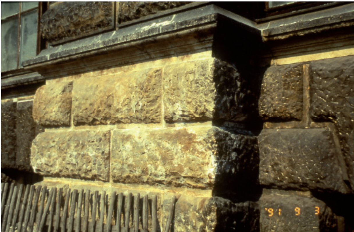
Abbildung 5: Salzausblühungen auf Sandsteinmauerwerk nach einem Reinigungsversuch mit Säure (Foto: H. Siedel)
