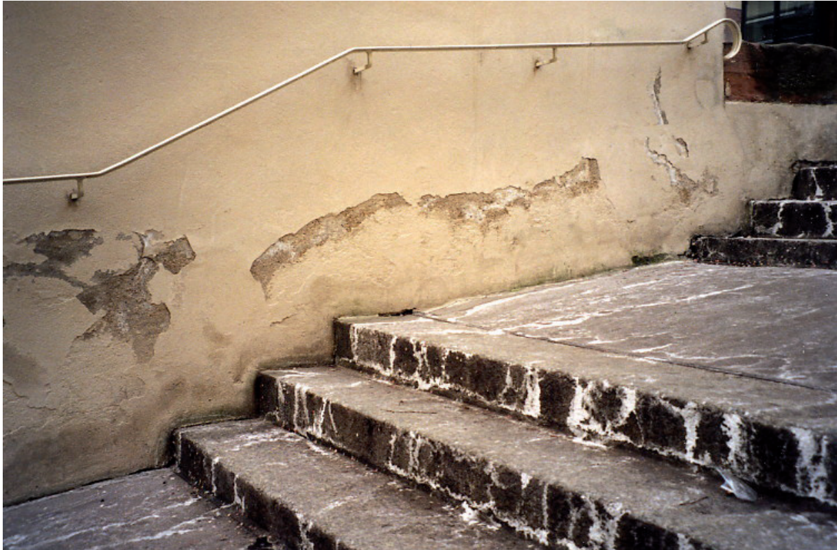
Abbildung 4: Streusalzreste auf einer Treppe in der Altstadt von Basel (Schweiz), Februar 2005 (Foto: H. Siedel)
