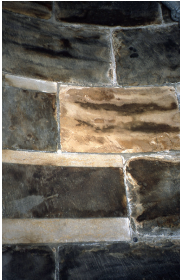
Abbildung 7: Salzbildung auf Postaer Elbsandstein durch trasshaltigen Fugenmörtel (Foto: H. Siedel)
