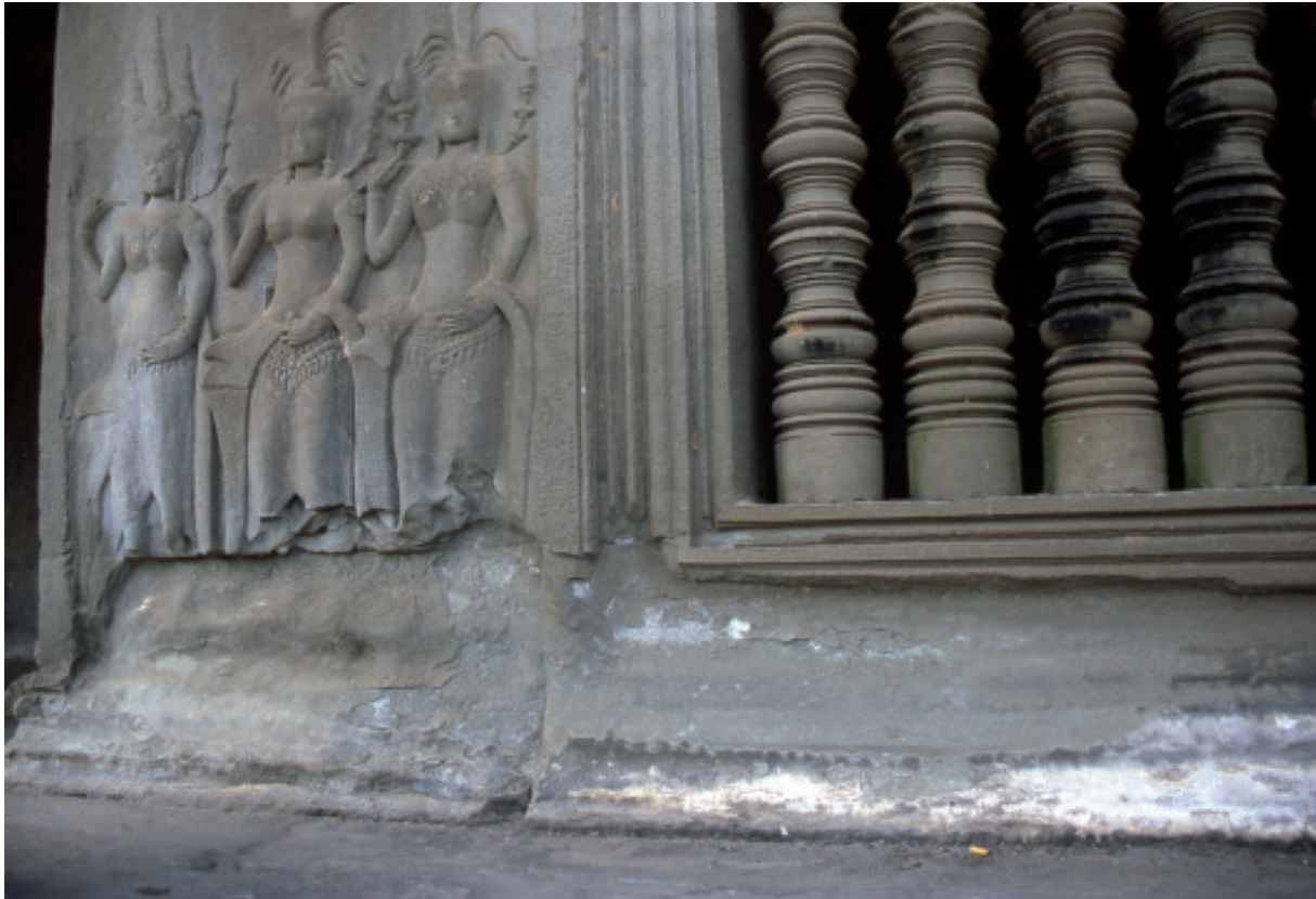
Abbildung 6: Salzbildung durch lösliche Stoffe aus Fledermausexkrementen, Tempel Angkor Wat, Kambodscha (Foto: H. Siedel)
