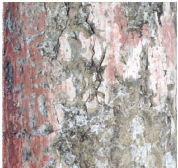
Abbildung 36 – Salzbelag auf einer Säule. Probeentnahmestelle: PS-
