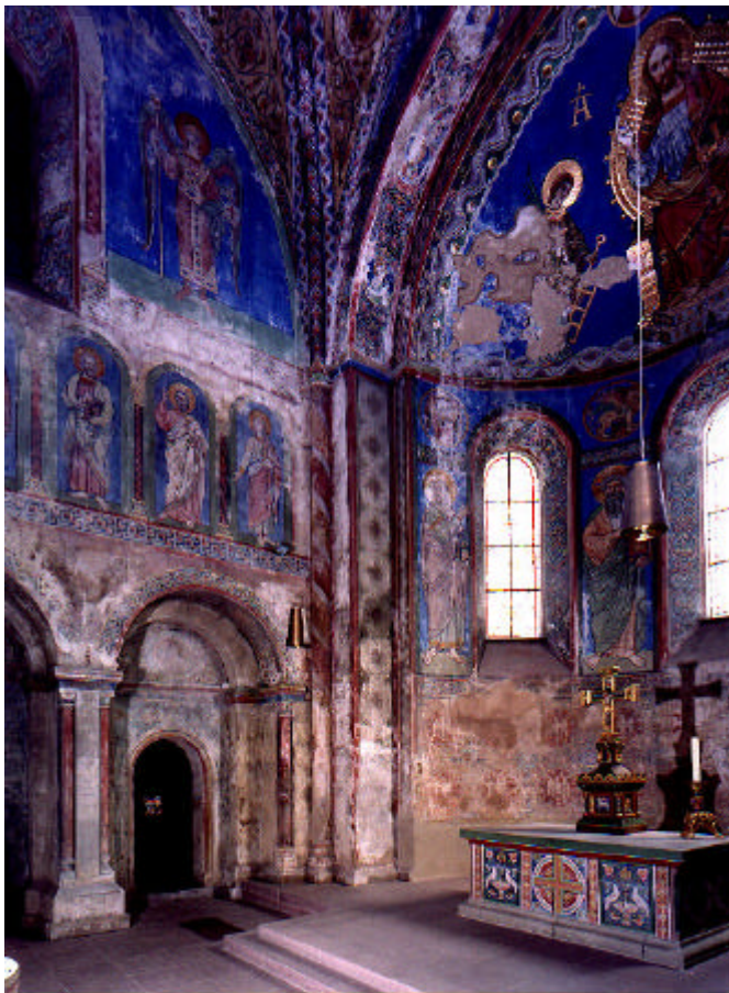
Abbildung 34 – Übersichtsdarstellung der Malerei des Chors. Blick nach Nordost. Aufnahmedatum: Juni 2000. Deutlich zu erkennen sind die großflächigen Fehlstellen von Verputz und Malschicht in der Kalotte
