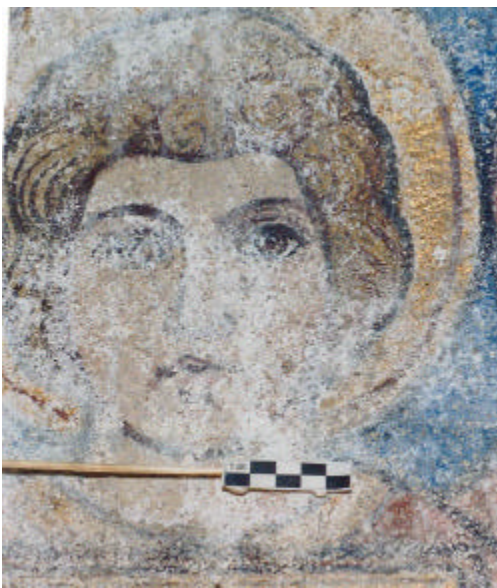
Abbildung 37 – Schadensphänomen einer Salzkrustenbildung
