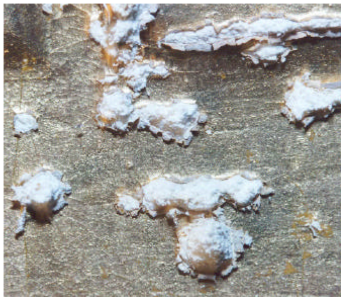
Abbildung 38 Aufgebrochene Salzpustel im oberen Bereich der Apsis. Probenummer PS-K.
