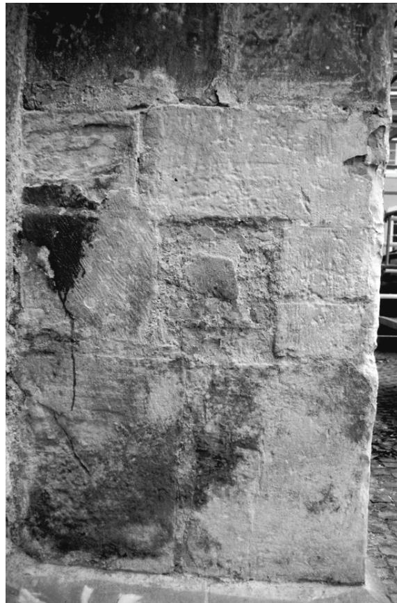
Abb. 8: Mauerwerksoberfläche nach Abnahme der Kaolin-Cellulose-Sand-Kompressen. Die Seitenlänge des Pfeilers beträgt etwa 1 m.
