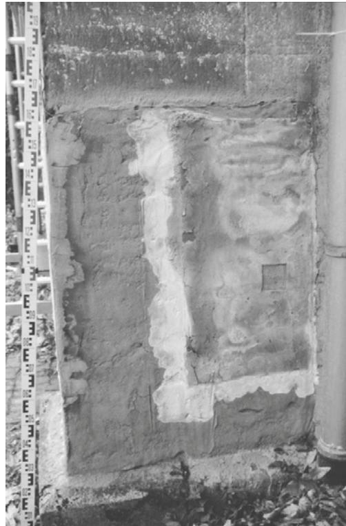
Abb. 13: Kompresse mit elektrochemischer Unterstützung im Bereich der Kathode.
