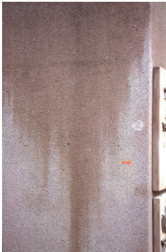
Abbildung 2: Schleierartige, weiße, stark haftende Überzüge auf zementgebundenem Kunststein auf einem Friedhof. Sie bestehen aus Calcit, Trona und Thermonatrit und stellen Auslaugungen der Zementmatrix durch Regenwasser dar. (Foto: G. Grassegger, MPA)
